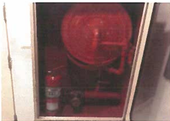
ตู้เก็บสายฉีดดับเพลิงพร้อมอุปกรณ์
